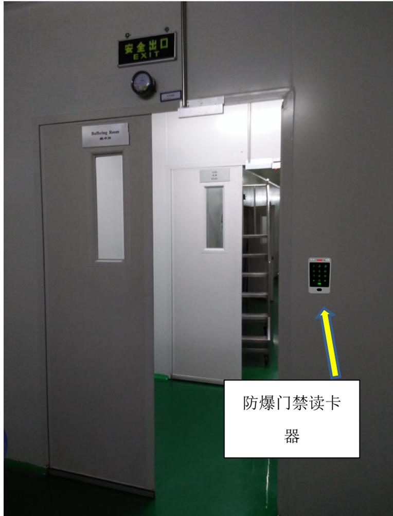
防爆门禁读卡器安装于门把手旁边墙体上,控制人员进出权限和人员进出记录,内外侧均需安装;
